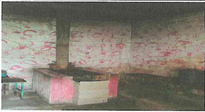
Foto1: Reparación de cocina, techo, plancha, azulejo y piso de cemento líquido.
