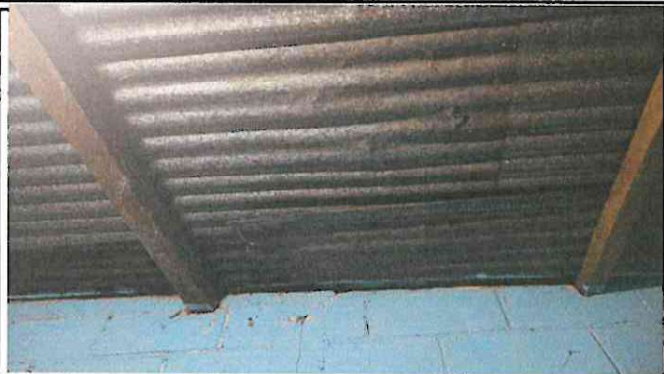
Foto1: Reparación de cocina, techo
