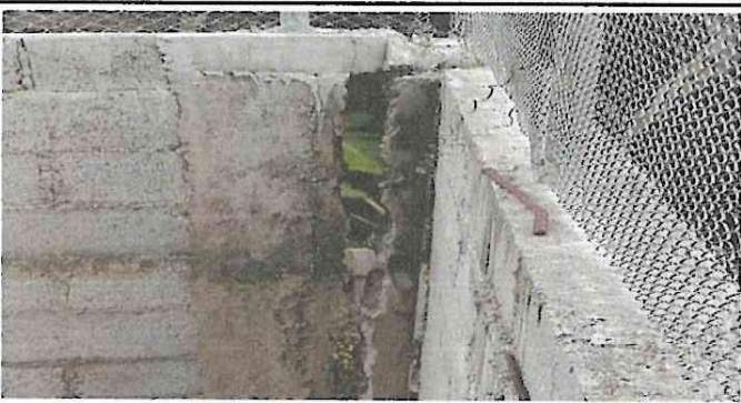
Foto 3: Reparación de muro perimetral de block
