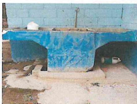
foto 5: reparación de pilas para el servicio de los niños
