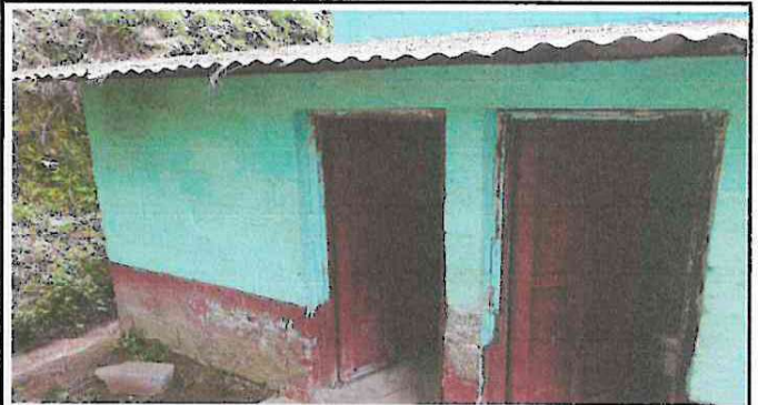
Foto 2: Reparación de baño, inodoros, techo, piso y pintura
