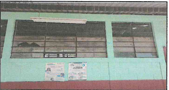
Foto 4: Reparación de ventanas y balcones
