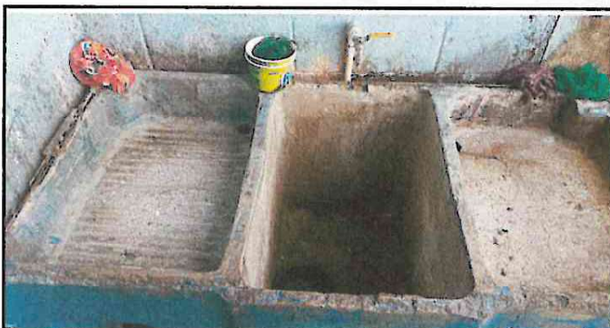
Foto 3: Reparación de pilas de la cocina
