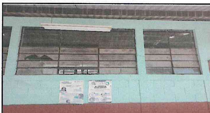
Foto 4: Reparación de ventanas y balcones
